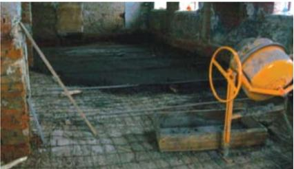
Мы сделали утепленные и ровные полы. Для этого мы сначала разломали и убрали верхнюю часть старого пола вместе с утеплителем, оставив при этом черновой пол на месте. Потом мы исправили повреждения, которые были в черновом полу, и укрепили его дополнительным слоем арматурной сетки, а потом залили все керамзитобетоном, а потом утеплили слоем пенополиэтилена и залили еще одним слоем керамзитобетона. Теперь по всему зданию мы имеем теплый и ровный бетонный пол.
